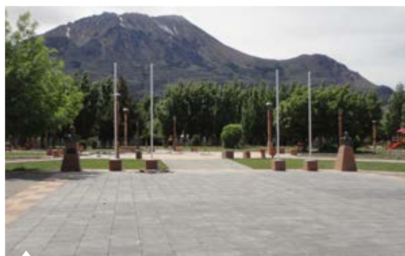
La plaza se intervino con el fin de potenciar y consolidar este centro cívico para los habitantes de la zona.
