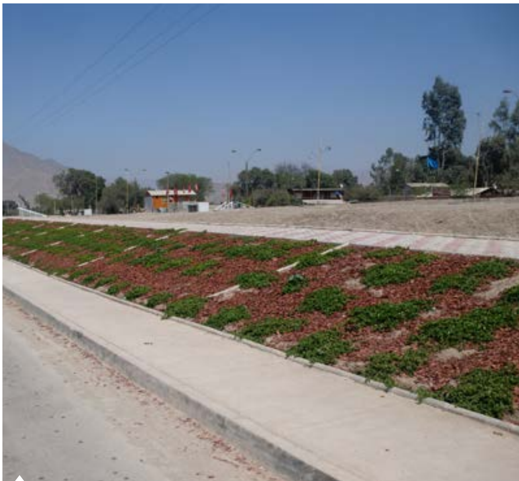
El parque involucra un total de 76 mil metros cuadrados y proveerá al lugar de paseos peatonales, ciclovías, multicanchas, juegos infantiles, alumbrado, mobiliario público y áreas verdes abiertas a la comunidad.
