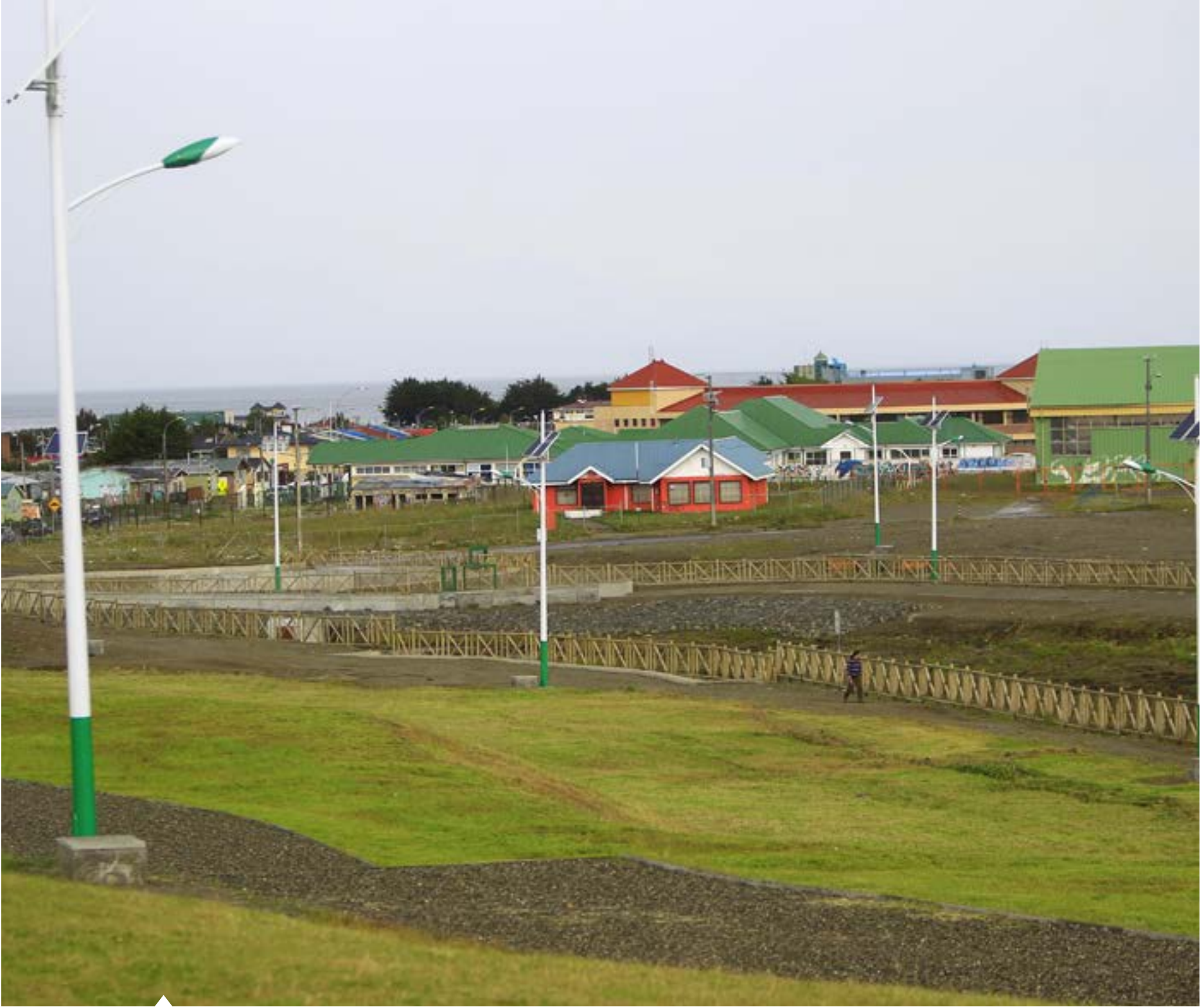
Este parque inaugurado en abril del 2013 solucionó los problemas de anegamiento por las lluvias durante los meses de invierno.
