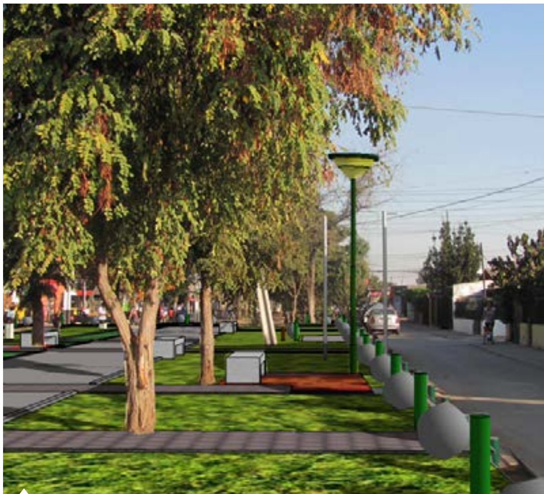
La obra comprende ciclovías, senderos, señalética e iluminación.
