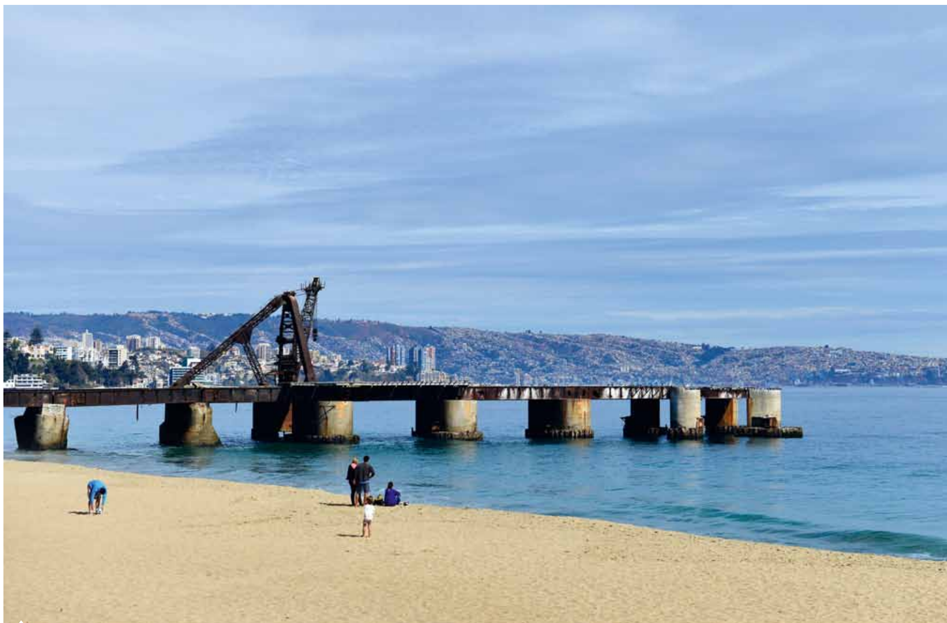
El Muelle Vergara pasó años abandonado y descuidado, llegando a un punto crítico en 2009, cuando un incendio destruyó lo que quedaba de las edificaciones sobre él.
