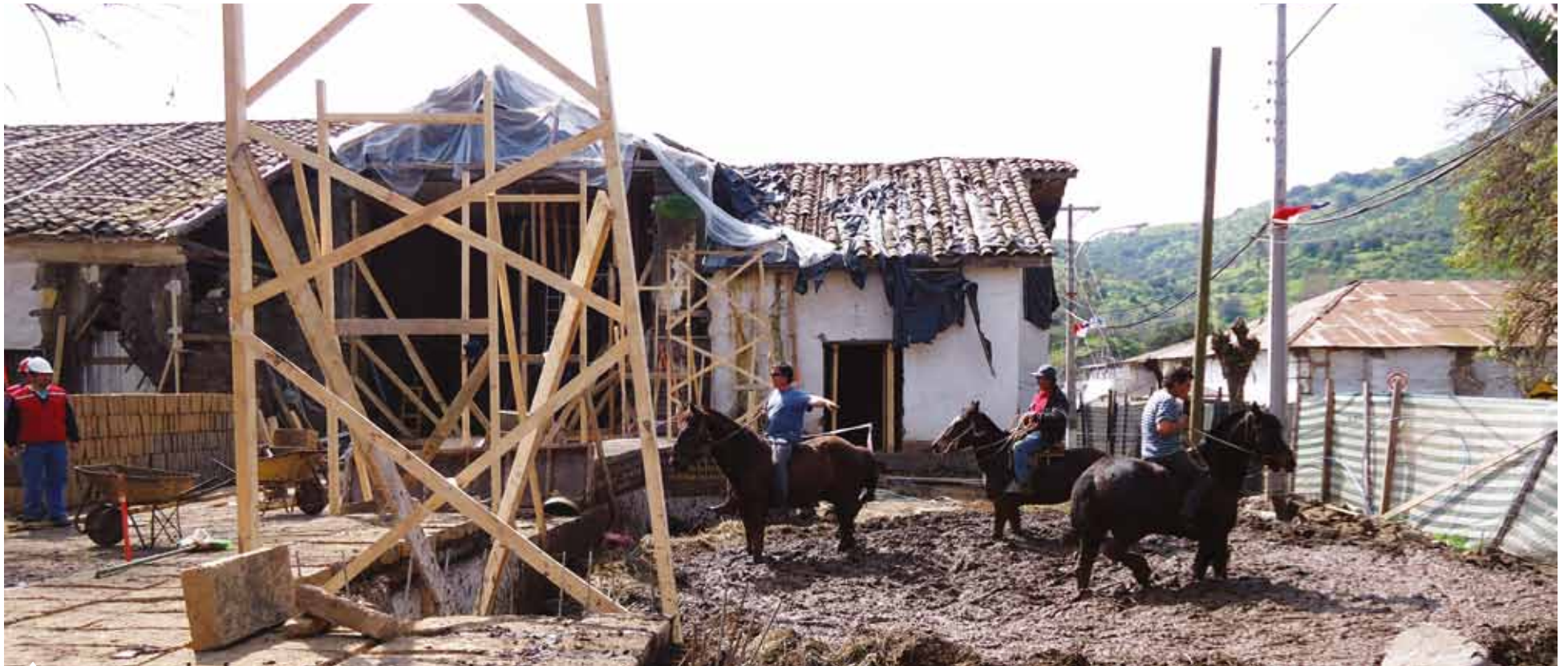
Trabajos de reconstrucción de los muros de adobe.
