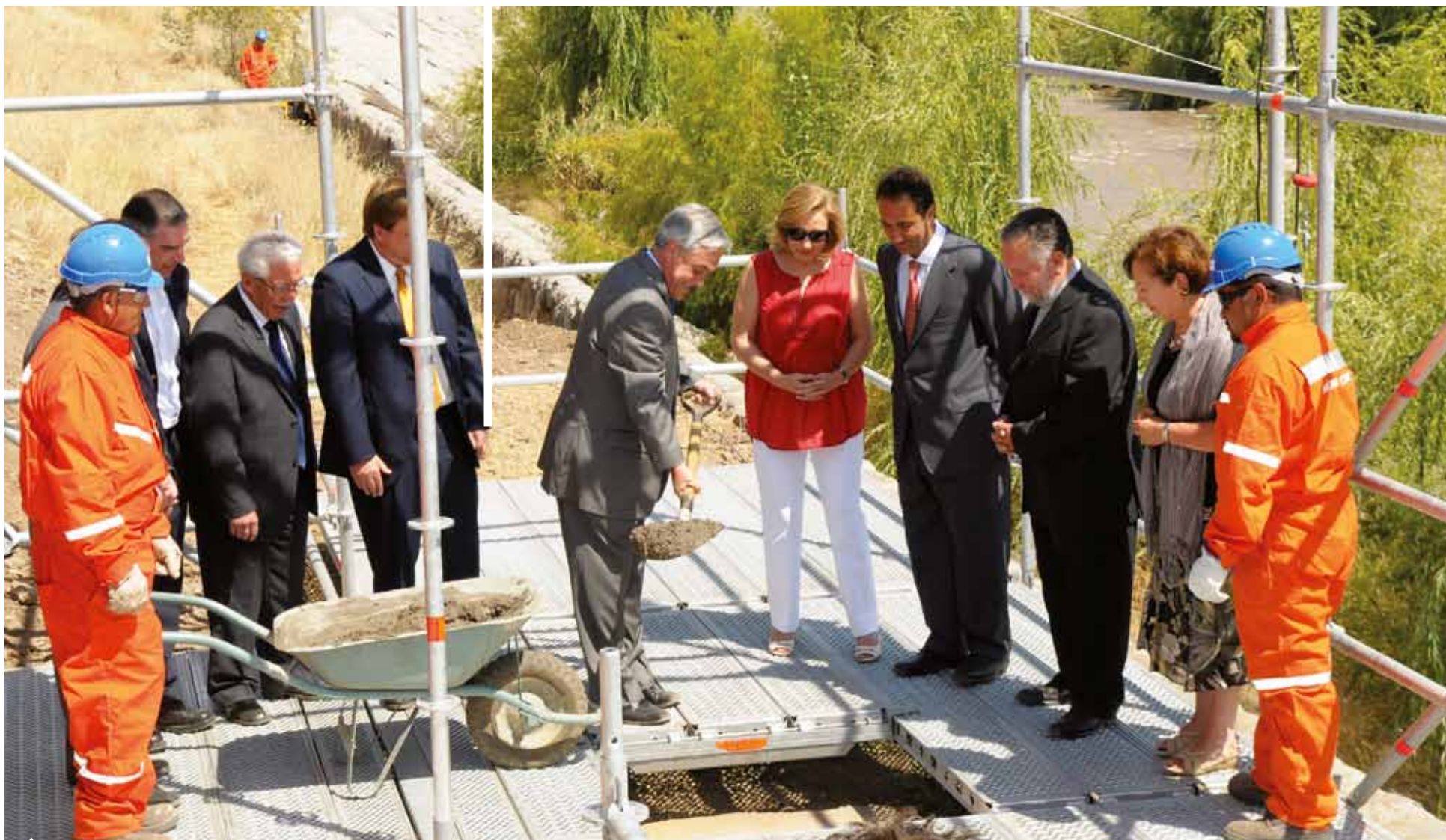
11.01.2011 | Con la instalación de la primera piedra, el Presidente de la República, Sebastián Piñera, dio el vamos a las obras.
