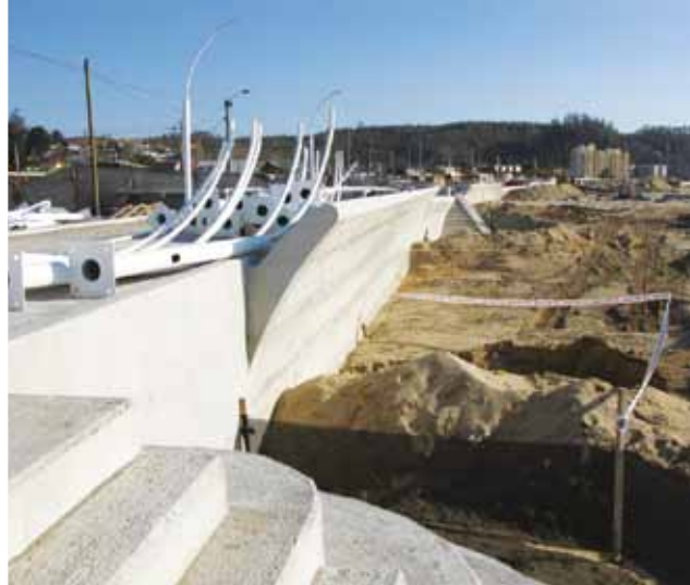
El nuevo borde costero incluyó la construcción de un muro de defensa de 820 metros lineales, tres mil 300 metros cúbicos de rocas de protección.
