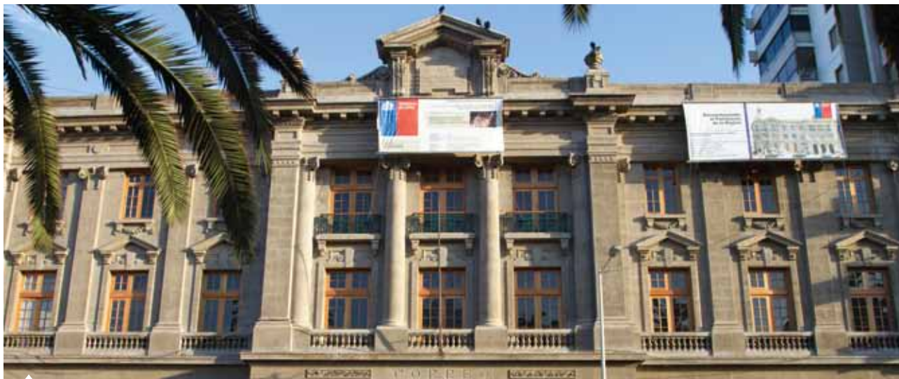
El edificio pasó a ser Monumento Nacional el año 2009.
