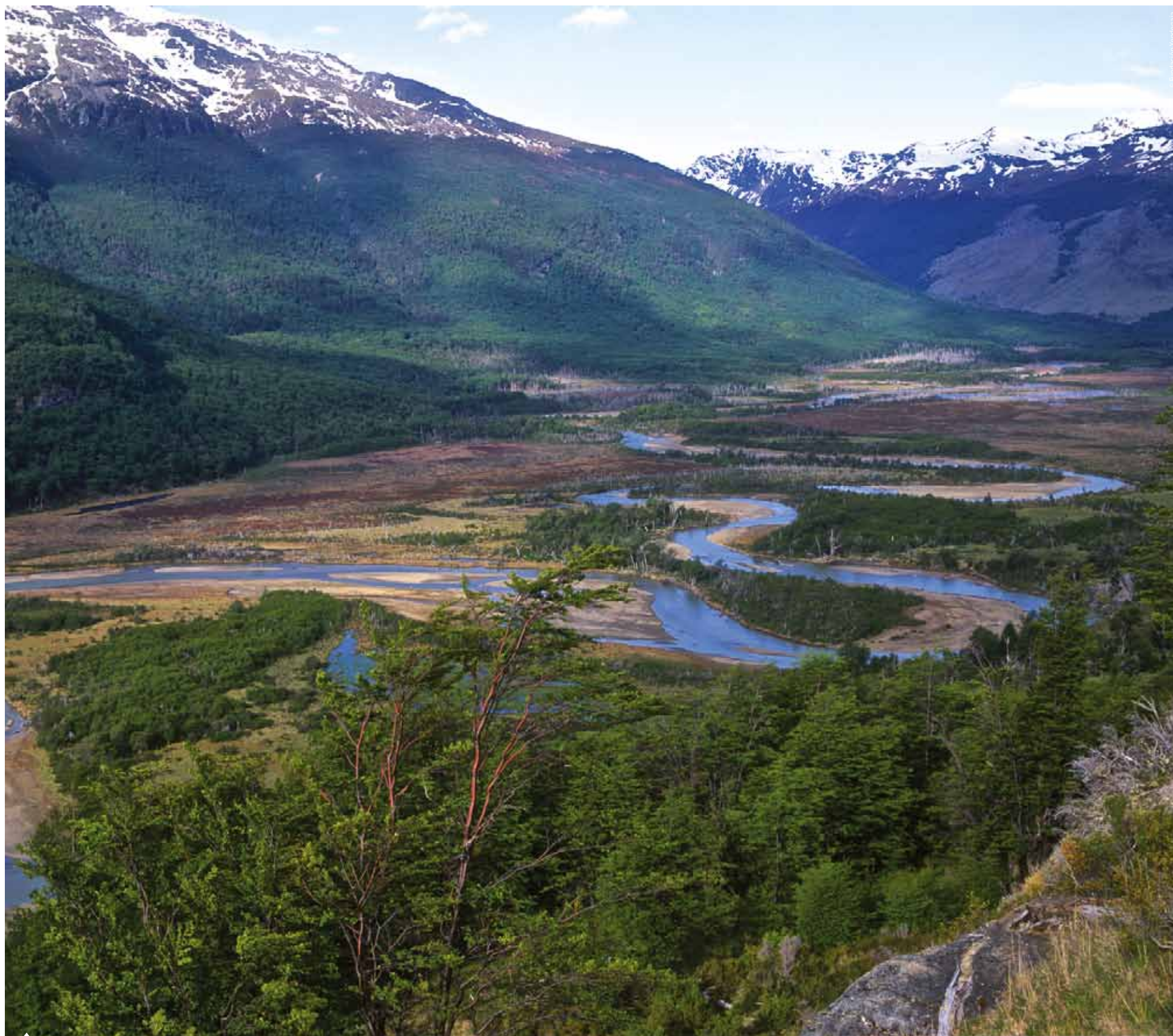
La construcción de la Ruta Y-85 entre la Estancia Vicuña y la bahía Yendegaia, en Tierra del Fuego, tiene un avance promedio mensual de 300 metros.
