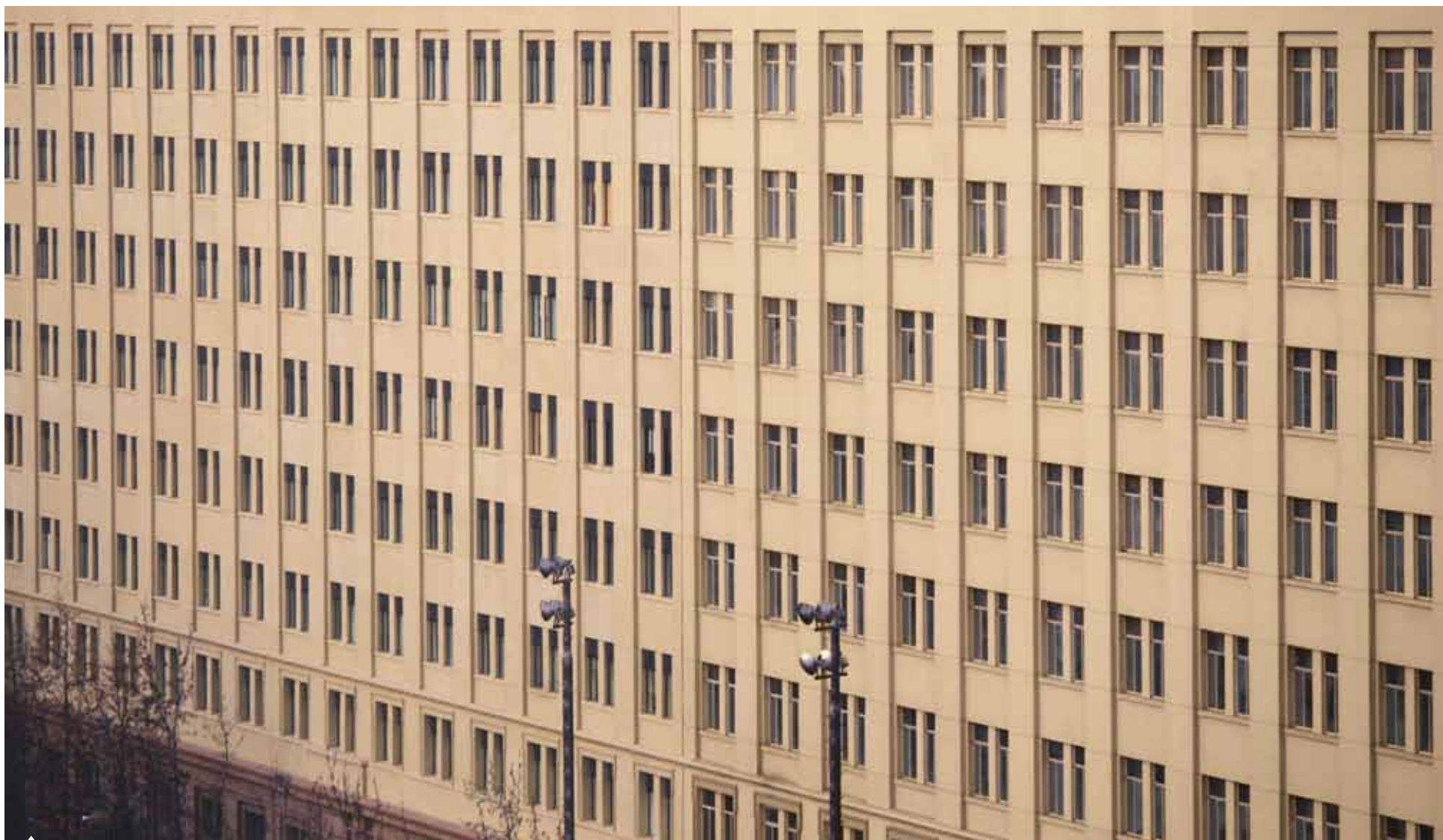
Gracias a esta restauración, se está recuperando el color, textura y solidez con que estos edificios fueron construidos a fines de los años 30.
