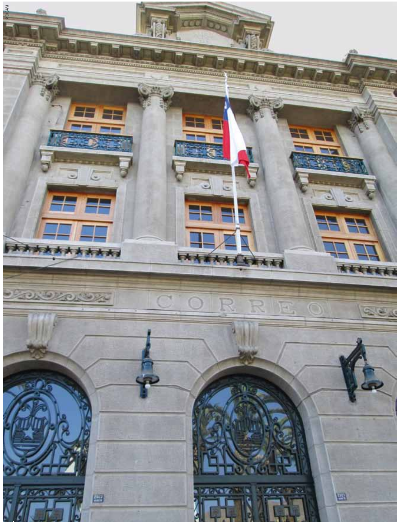
La nueva Biblioteca Regional ocupa el ex edificio de Correos de la ciudad de Antofagasta.
