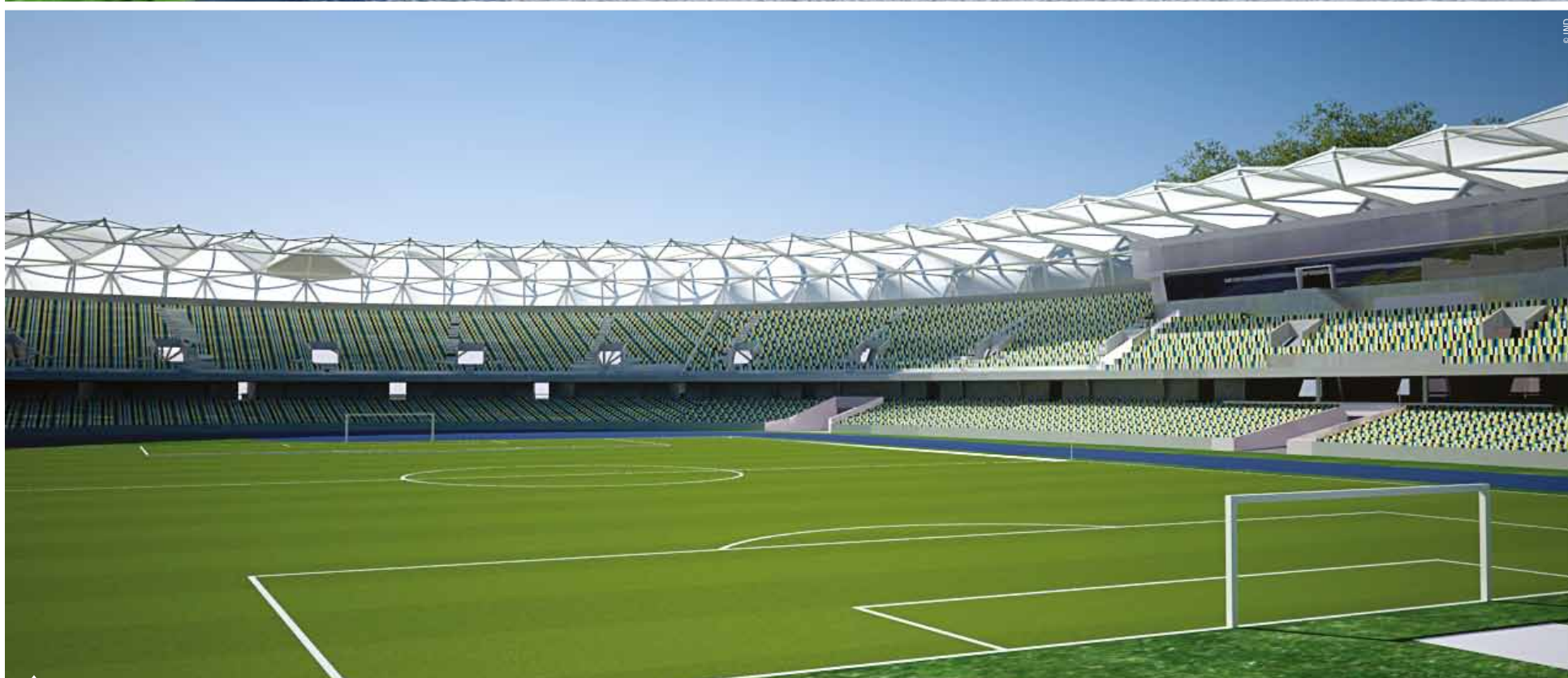
Parte del Plan ChilEstadios liderado por el IND, contará con estándar FIFA, con cubierta sobre las graderías y capacidad para más de 30 mil espectadores.
