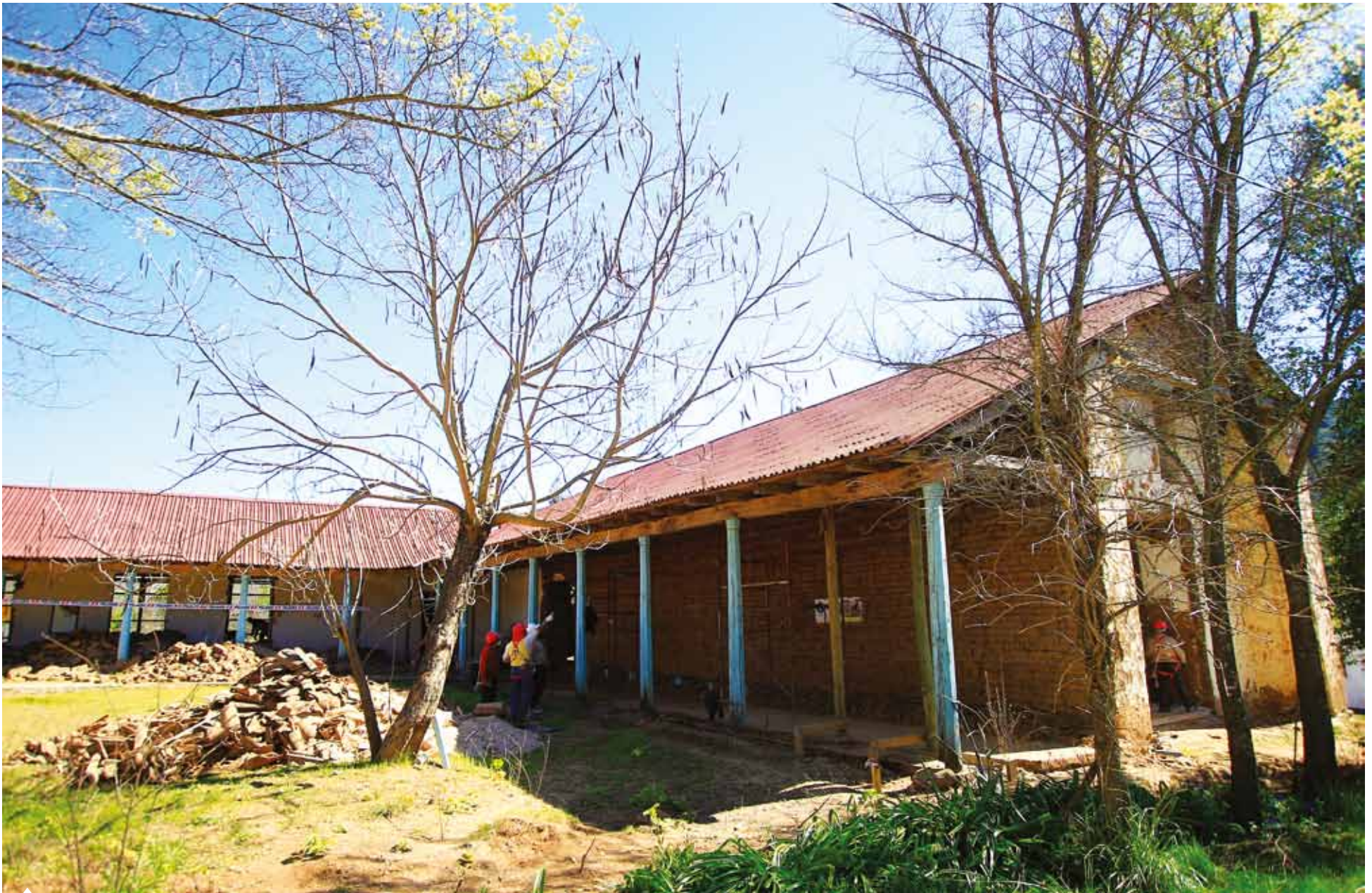
Capilla Nuestra Señora del Carmen de Batuco al iniciar los trabajos de restauración.
