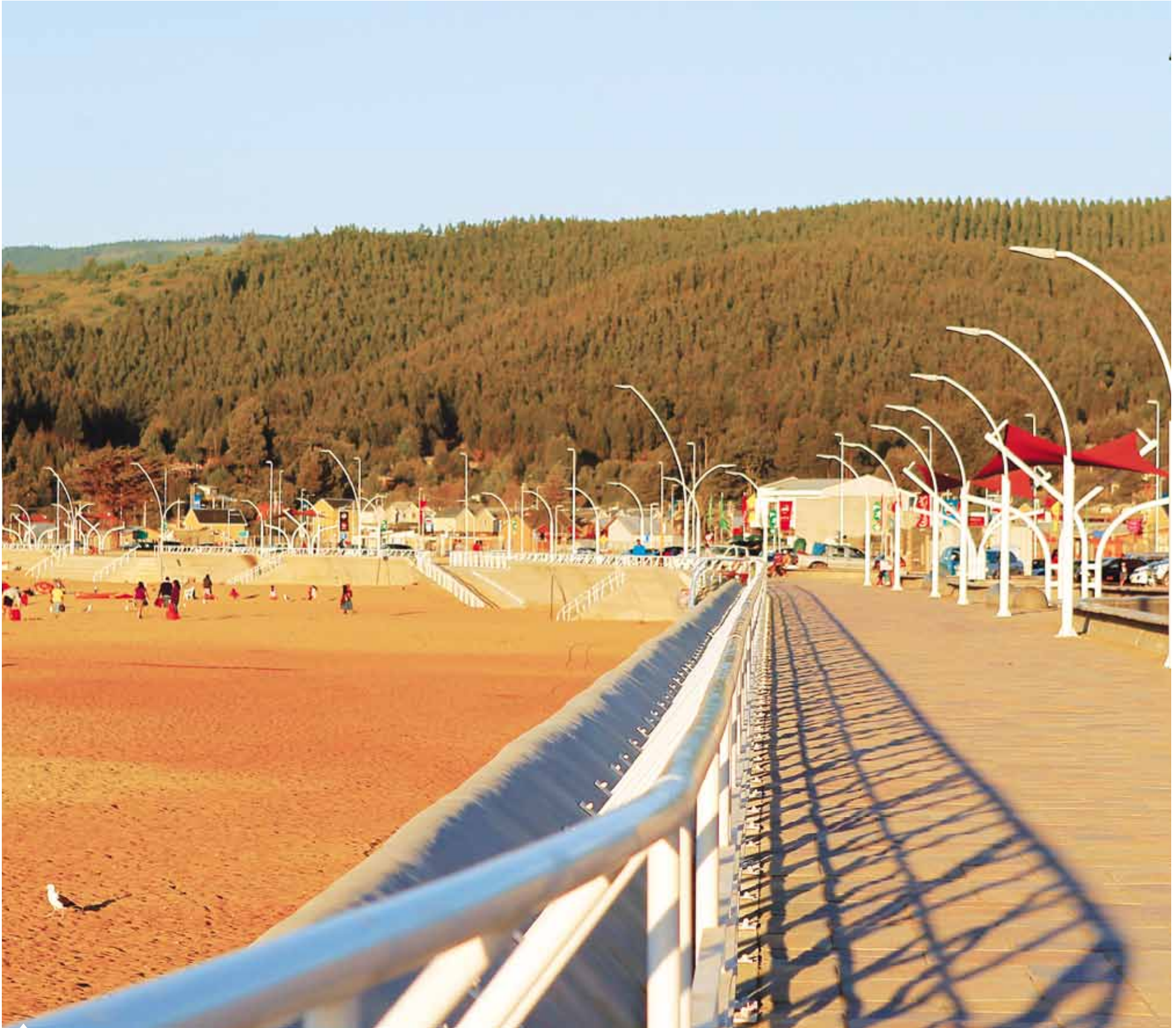
La nueva Costanera de Dichato fue construida tras el tsunami que afectó la zona el 27 de febrero del 2010.
