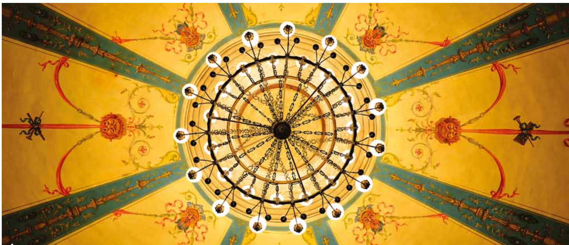
Inaugurado en 1889 se encontraba cerrado desde el año 2007 por problemas en sus instalaciones.
