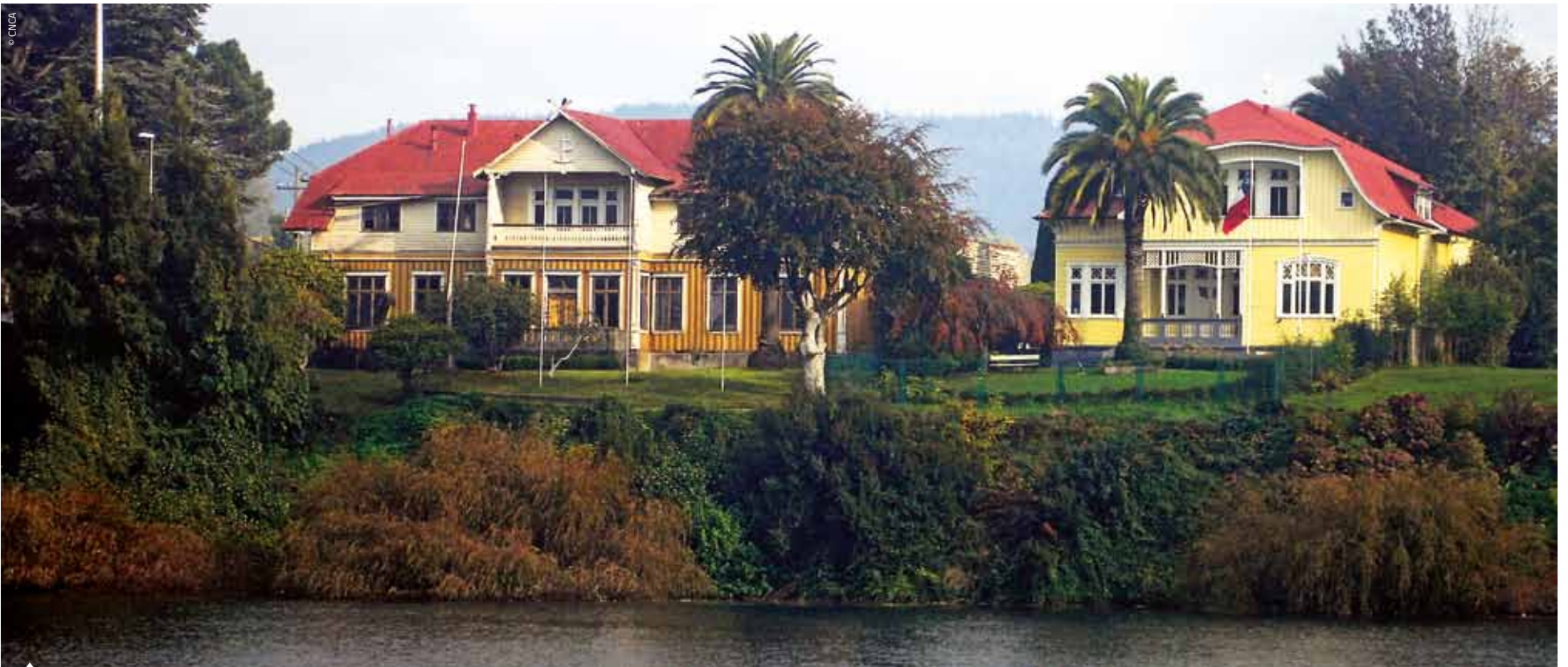
En Valdivia se restauró y habitó la Casa Prochelle, considerada Monumento Nacional, para transformarla en un centro cultural.
