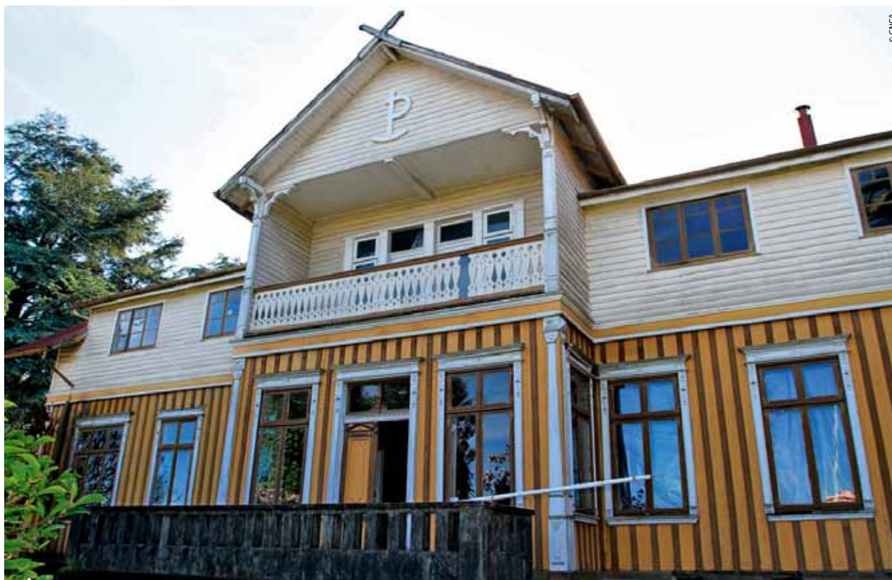
Se intervinieron los 2 mil 294 metros cuadrados donde se emplaza la casa, y particularmente los 730 metros cuadrados de superficie construida en dos niveles.
