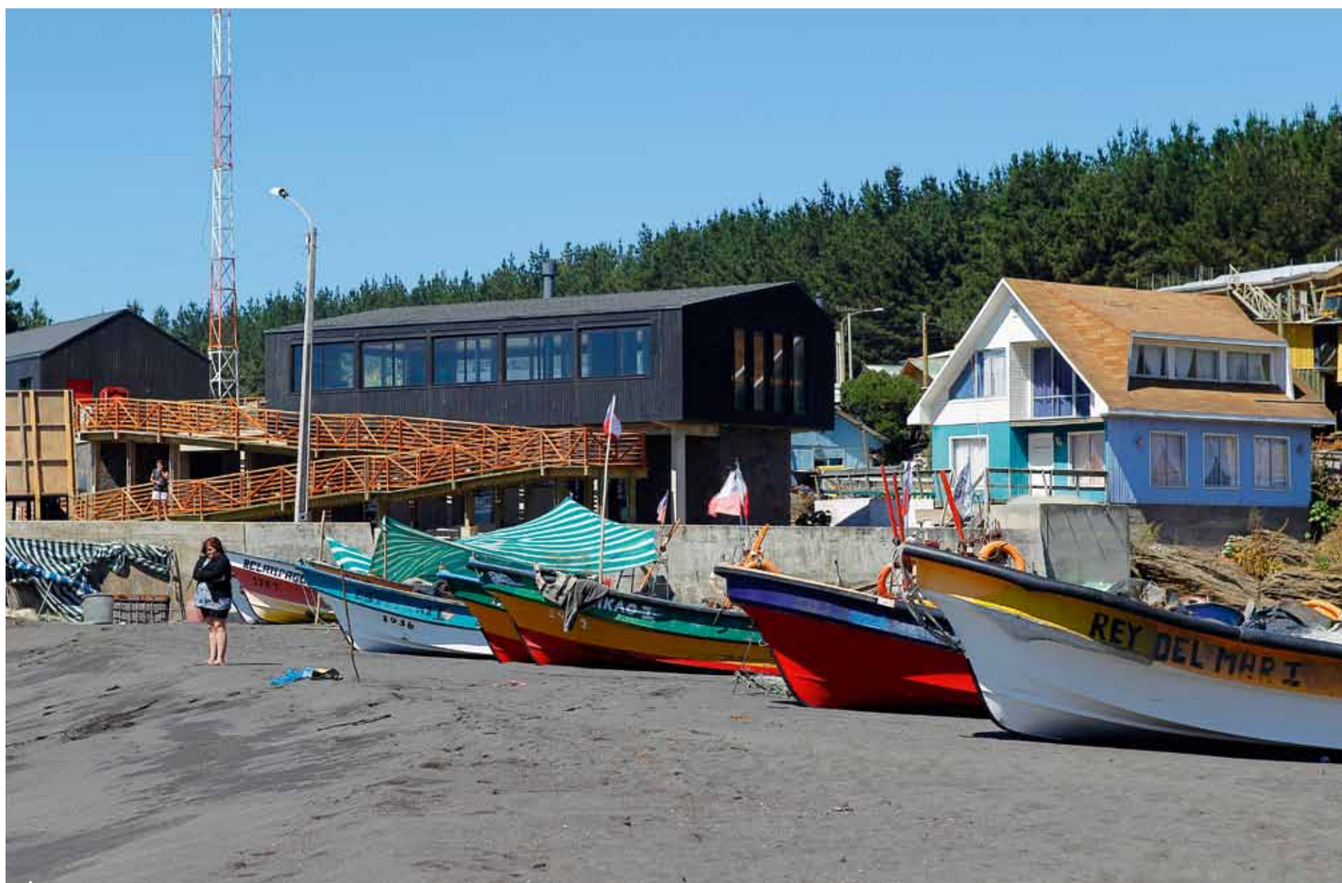
El proyecto consideró la construcción de la infraestructura pesquera básica.
