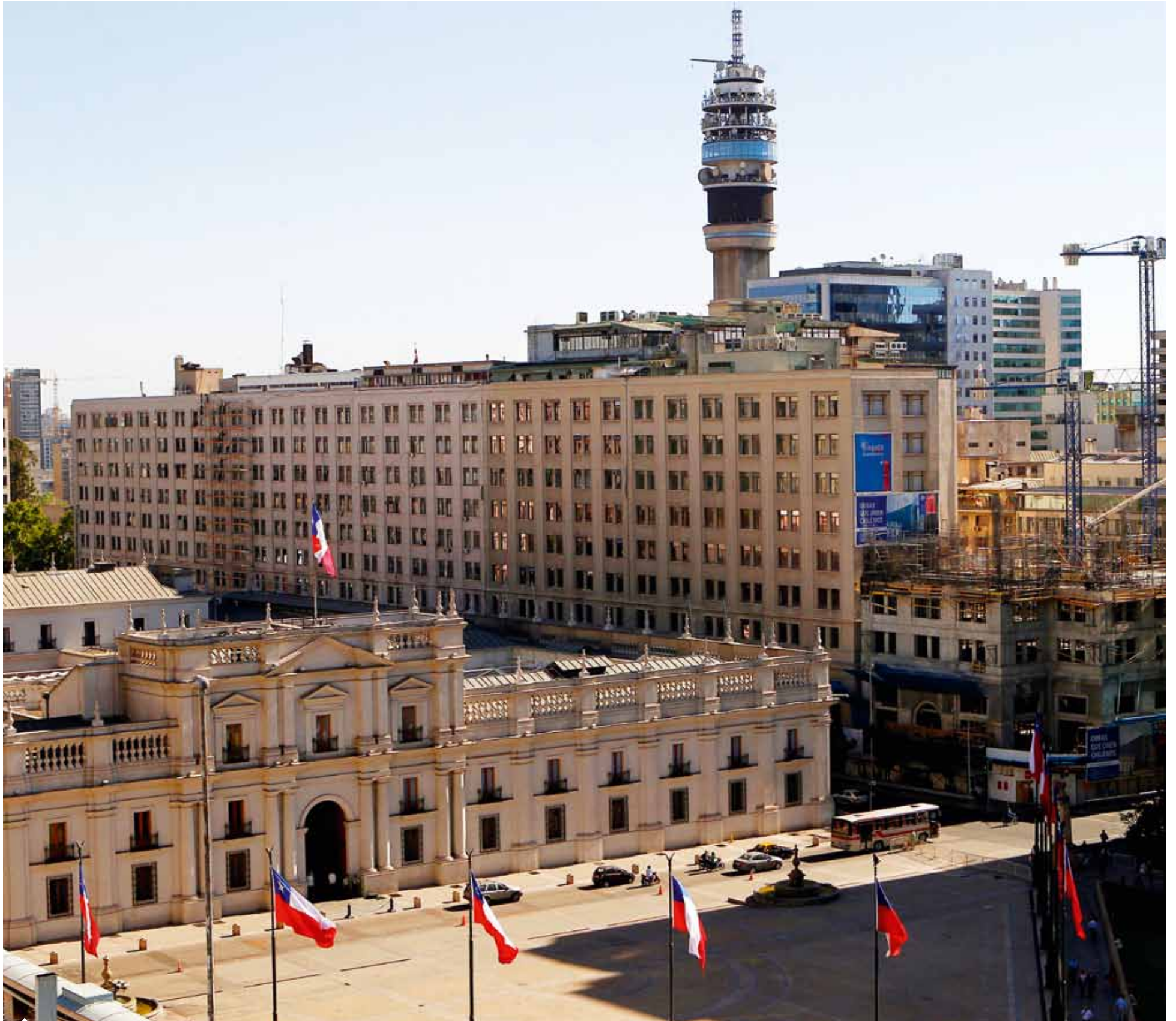
La construcción del edificio Moneda Bicentenario comenzó en octubre de 2011.
