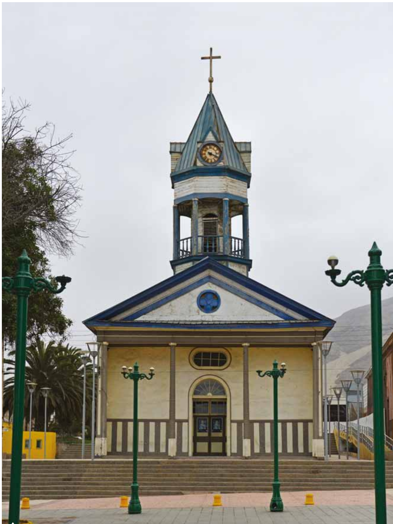
Iglesia Nuestra Señora del Carmen de Chañaral, en el estado que se encontraba antes de su restauración.
