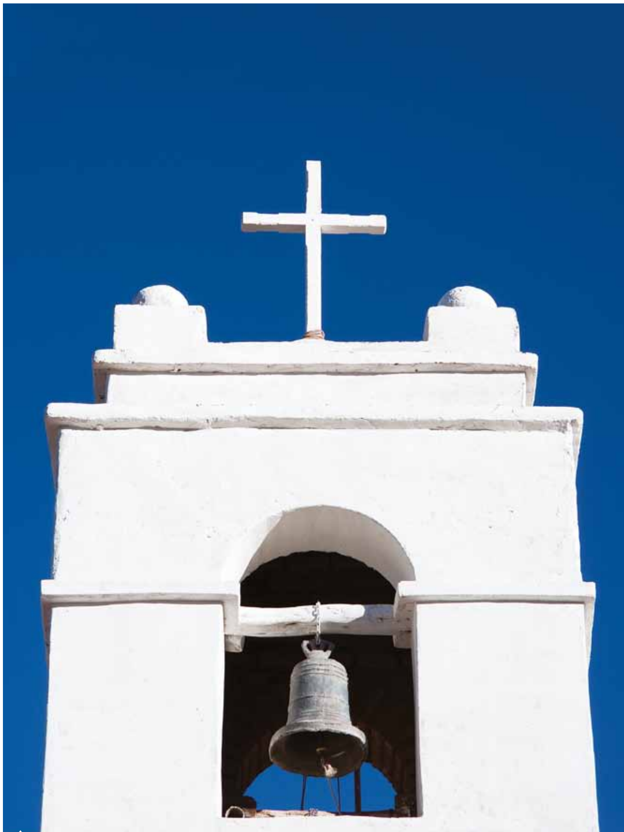
La restauración consideró un nuevo estucado, pintura exterior y cierre perimetral.
