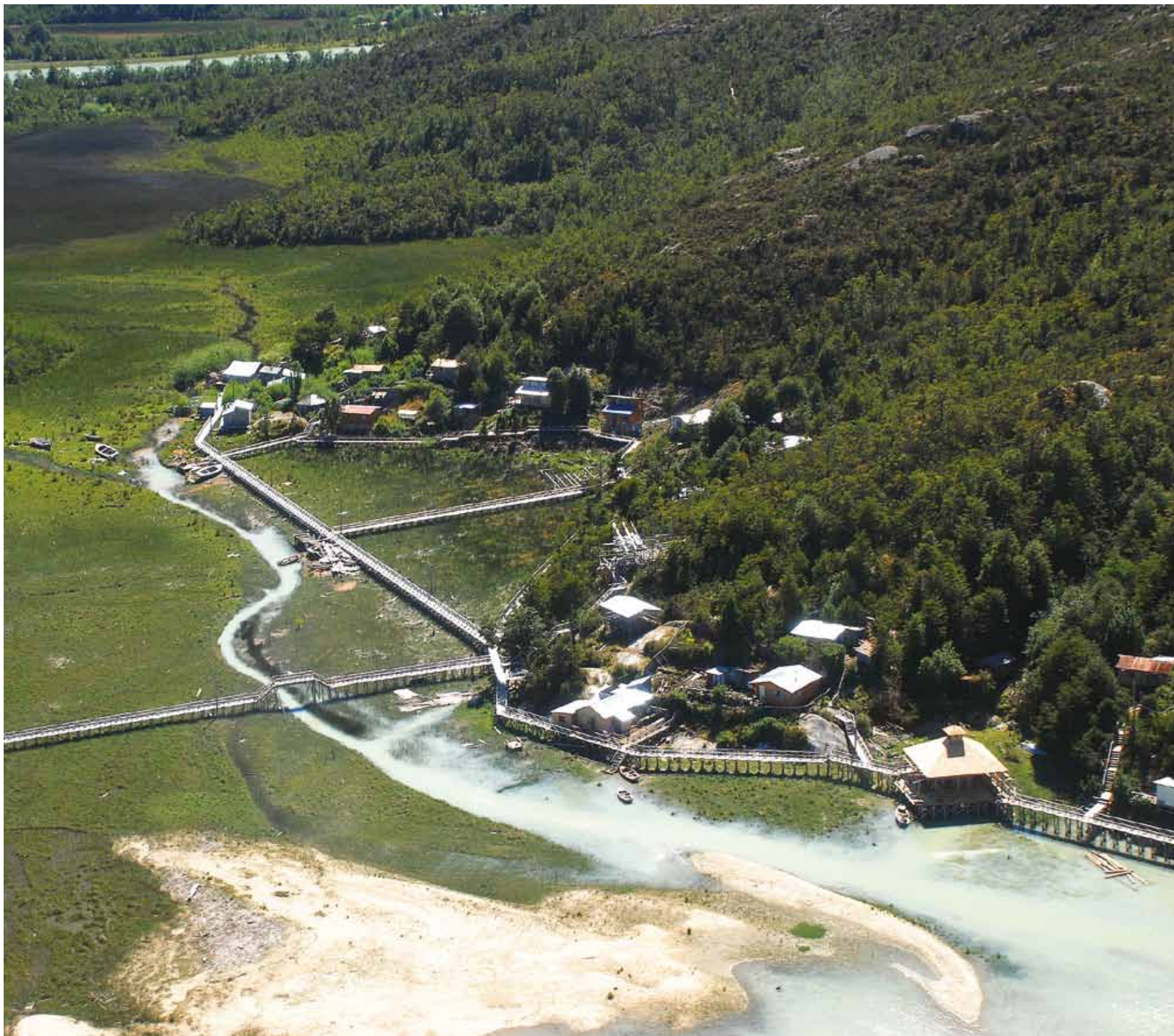
Una vista aérea de Caleta Tortel, donde se aprecia el mejoramiento y ampliación de los mil metros de pasarelas peatonales que mejoran la conectividad de la zona.
