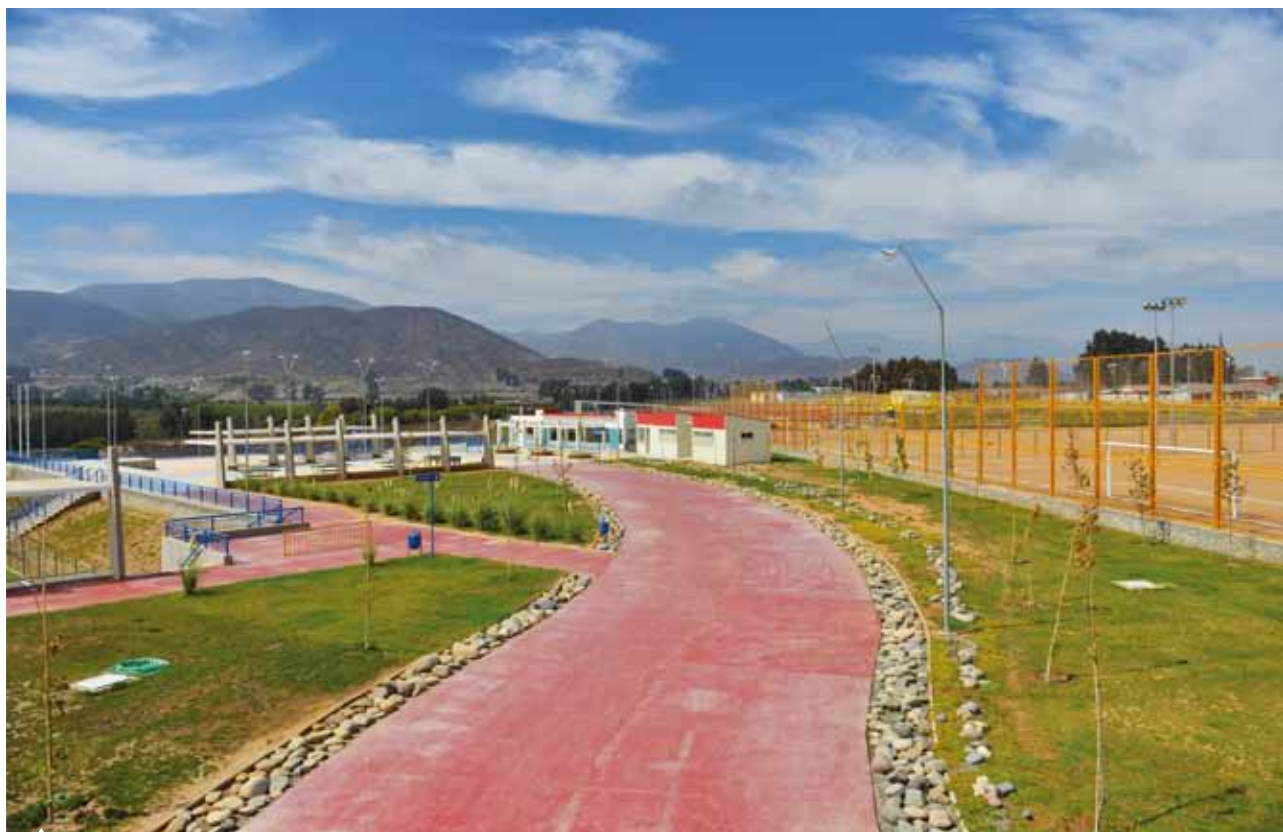
Las instalaciones benefician a cerca de 80 mil vecinos de la comuna de Coquimbo.
