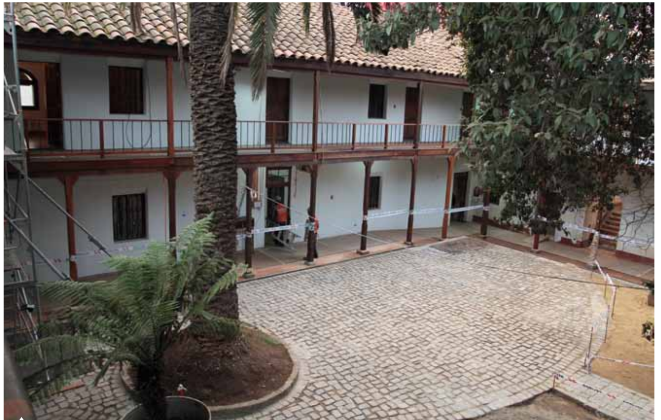
La restauración contempla la reparación de sus estructuras, priorizando la torre de la iglesia, sus naves y el convento.
