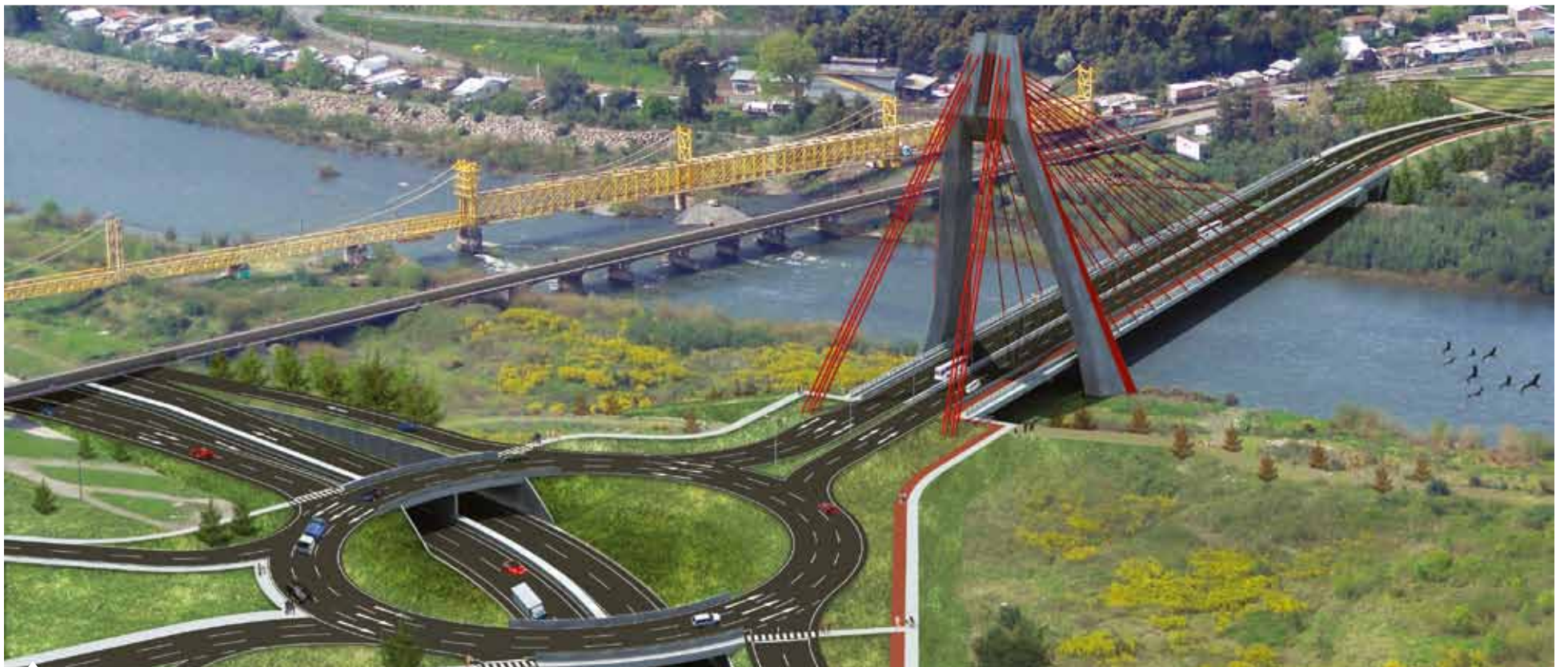
El nuevo puente beneficiará a los más de 70 mil habitantes de Padre Las Casas, en la Región de La Araucanía.
