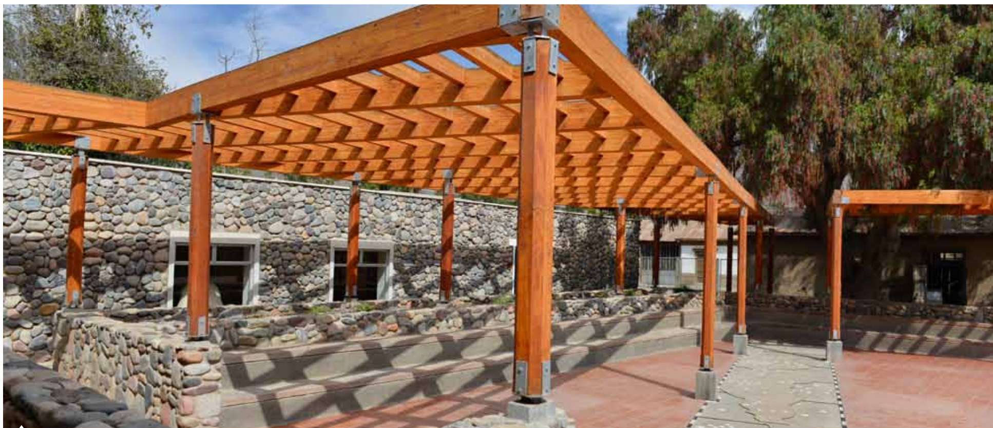
La remodelación del Museo Gabriela Mistral en Vicuña incluye el trazado de una línea diagonal sobre el total del terreno del Museo, una recta que une el lugar con la tumba de la poetisa en Monte Grande.
