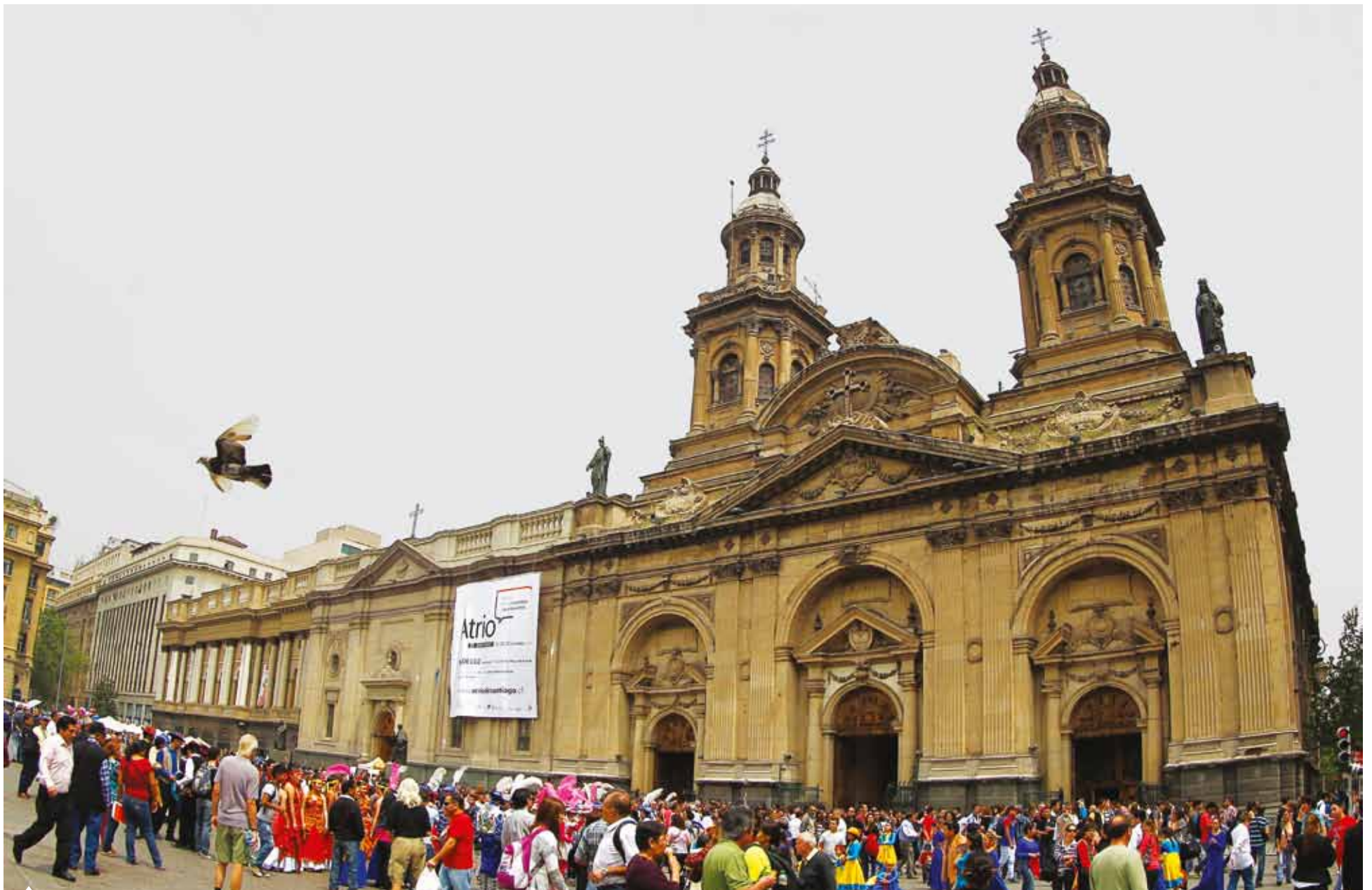
Dentro de los trabajos que se realizarán están la consolidación de las fachadas y las torres, reparación de las murallas e implementación de un nuevo sistema de iluminación, entre otras cosas.
