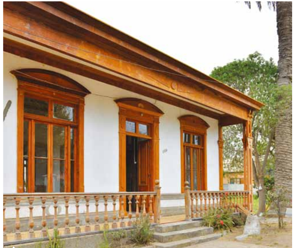
Vista del trabajo de restauración de la Casa de Las Palmeras ubicada en La Serena.
