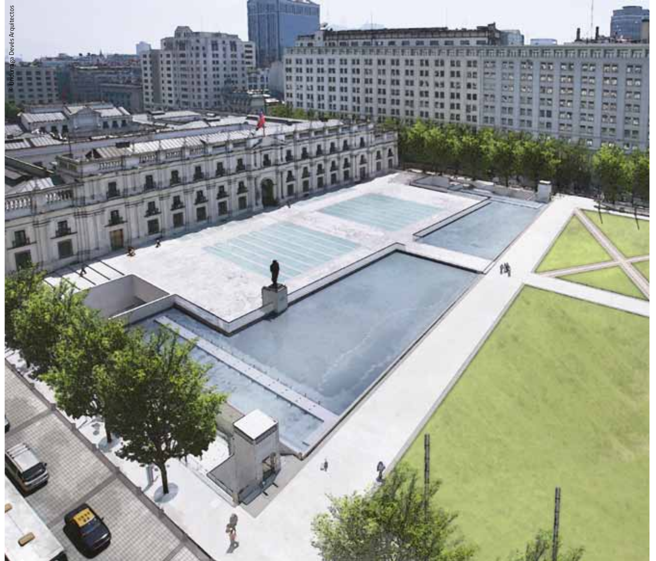
La Plaza de la Constitución, la de la Ciudadanía, la Alameda y el comienzo del Paseo Bulnes se unirán en una sola explanada de 94 mil metros cuadrados.
